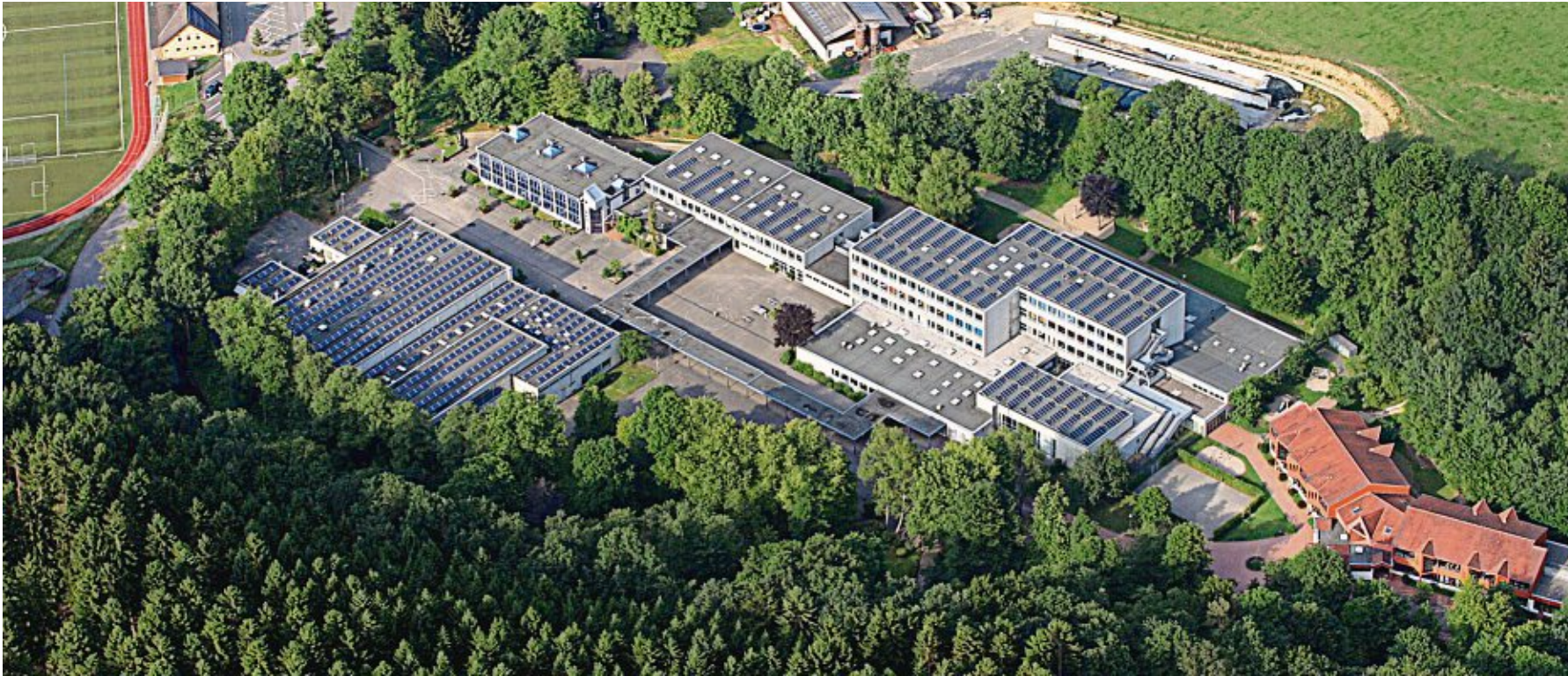
Zu Beginn des Jahres 2022 wird in Kürten die Sanierung der Schulgebäude starten. Die Politik hat den Zeitplan bestätigt.
