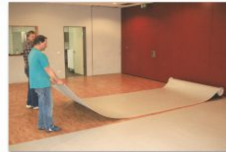
Verlegung mit Belagrollis
