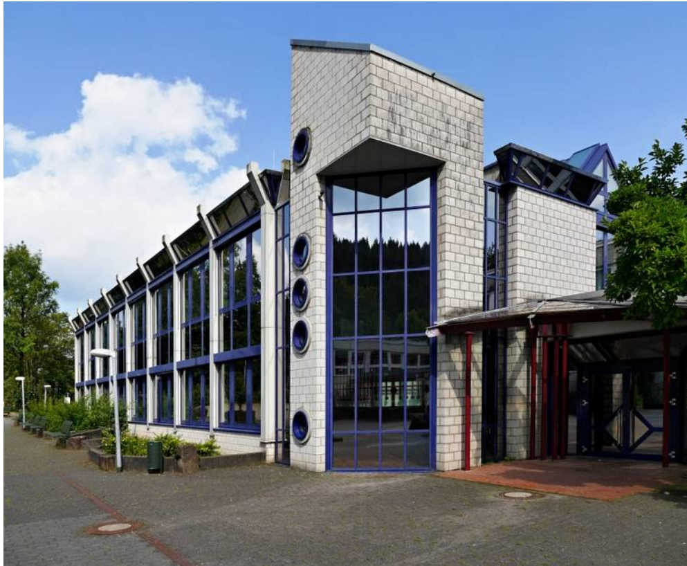
Abbildung 3: Südwestansicht Gebäude S
