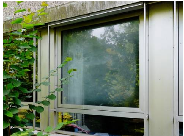
Abbildung 12: Blinde Scheibe in Fenster im EG Gebäude N
