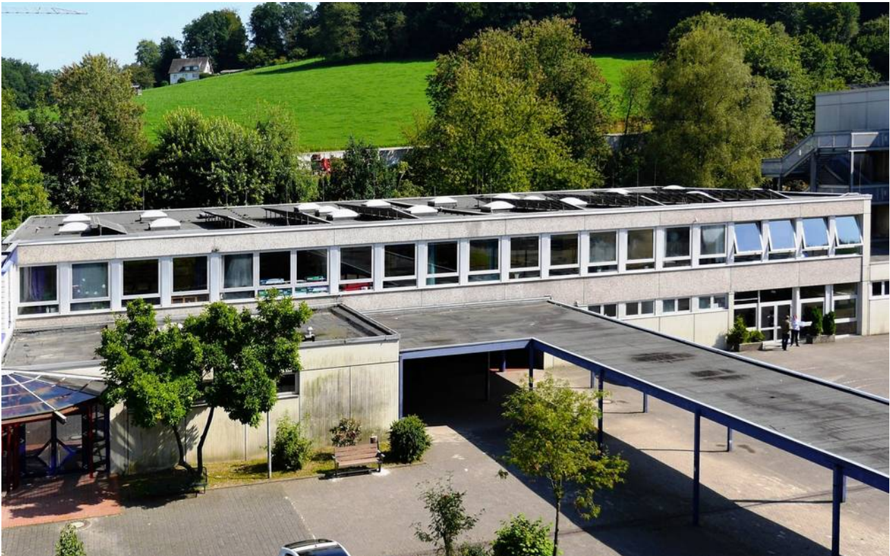
Abbildung 9: Westansicht Gebäude N
