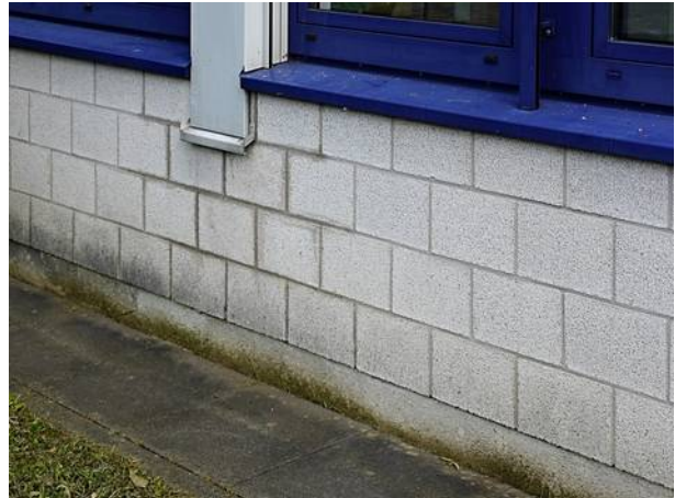
Abbildung 4: Sichtsteinmauerwerk am Sockel Gebäude S
