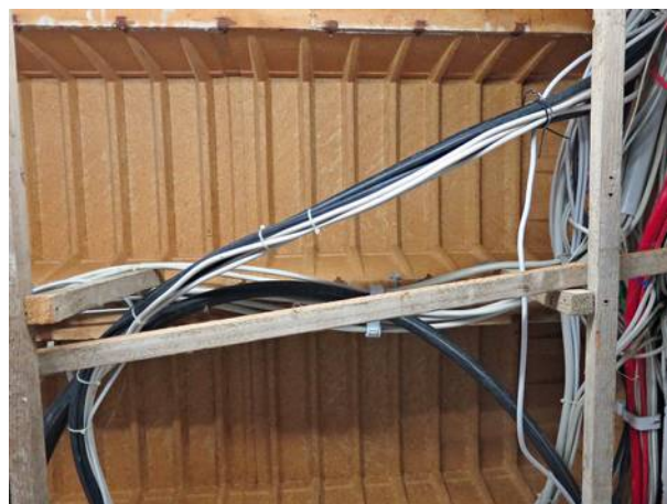
Abbildung 17: Elektroinstallation im Deckenbereich
