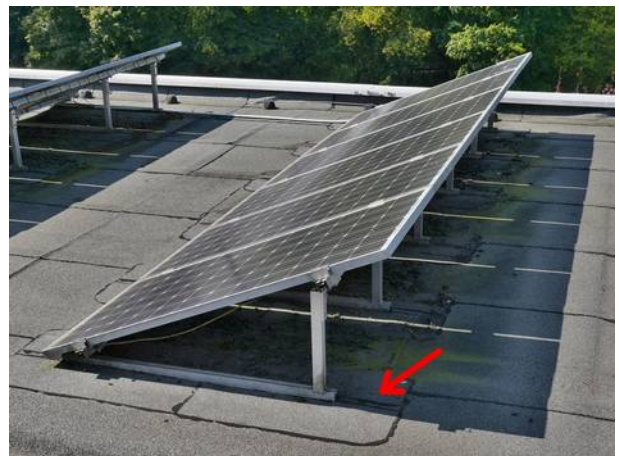
Abbildung 23: PV-Module mit Klebemontage (Pfeil)
