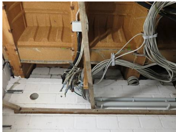
Abbildung 10: Rippendecke von unten, Holzwerkstoff-Schalelemente sichtbar
