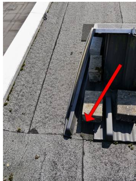
Abbildung 33: gebrochene und ausgebleichte Kunststoffwanne als Modulträger
