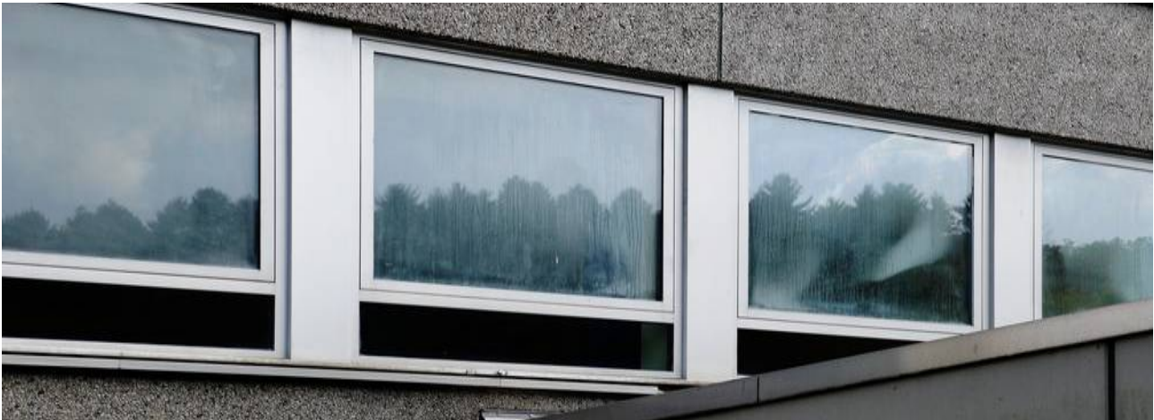
Abbildung 21: Blinde Scheiben in einem Klassenraum Bauteil H
