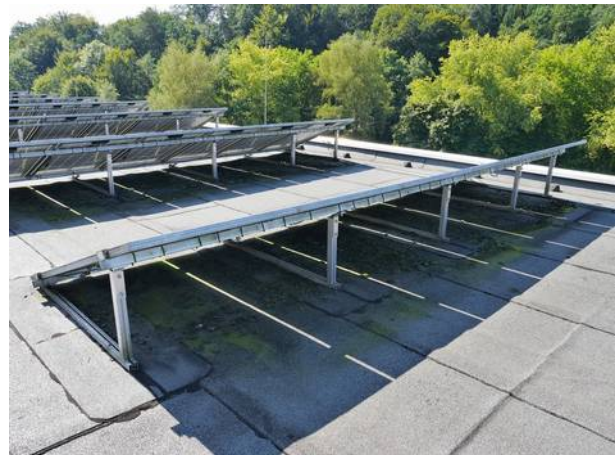
Abbildung 32: geklebte Unterkonstruktion auf der Schule
