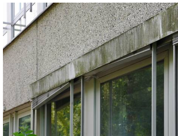
Abbildung 11: Detail Ostfassade Gebäude N
