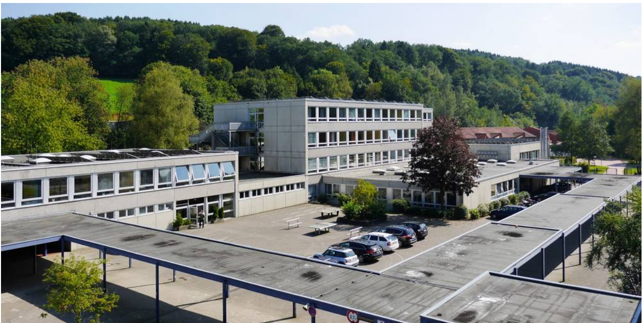
Abbildung 1: Gebäude N und H
