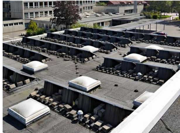
Abbildung 31: PV-Anlage auf der Sporthalle
