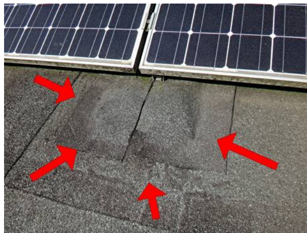
Abbildung 35: Dampfblase im Bereich der Befestigungslasche
