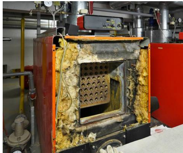
Abbildung 24: Geöffneter Brennwertkessel
