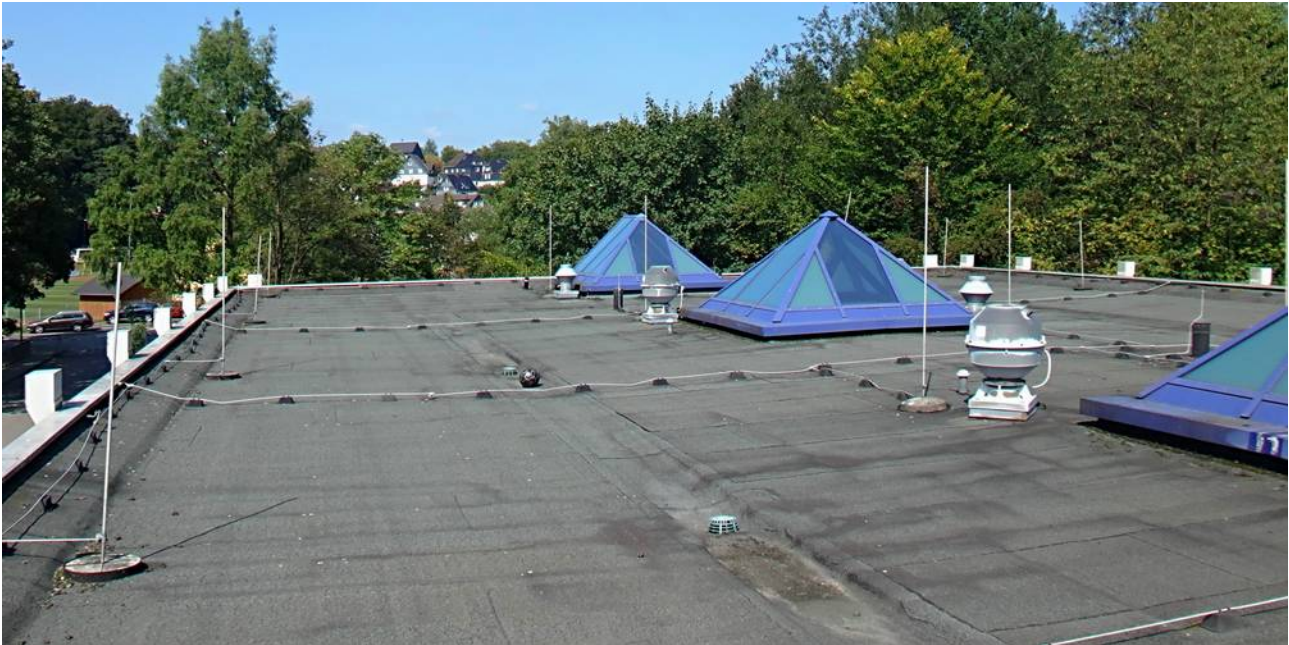
Abbildung 5: Flachdach Gebäude S mit "Lichtkuppeln"
