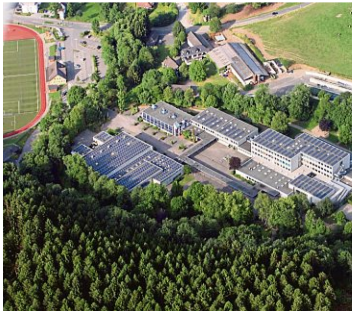
Das Schulzentrum in Kürten: Politik, Verwaltung und Schule ringen um Ausbau und Sanierung. Foto: Wagner
