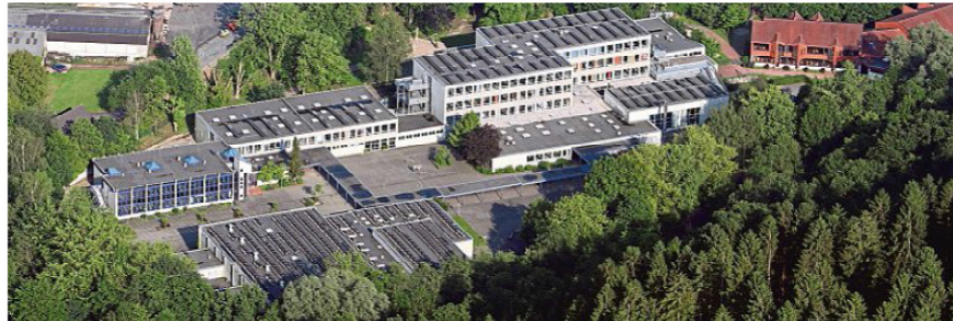
Die Sanierung der Gesamtschule Kürten ist umstritten.
