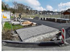
Der neue Parkplatz für 48 Autos nimmt Form an. Foto: Arlinghaus
