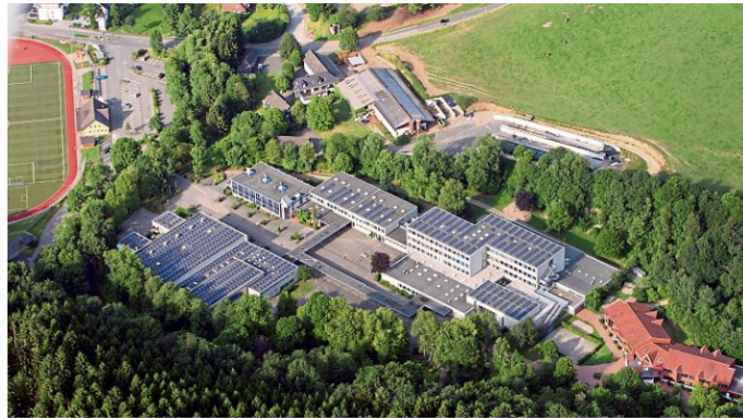
Über die weiteren Schritte in Sachen Sanierung des Schulzentrums wird im Frühjahr 2024 entschieden.
