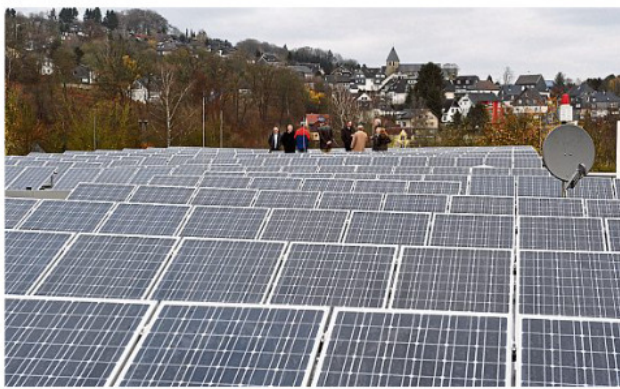
Im November 2010 ging die Photovoltaikanlage des Energieversorgers BEW in Betrieb. 900 Module gibt es auf den Dächern von Gesamtschule und benachbarter Turnhalle. Archivfoto: Arlinghaus
