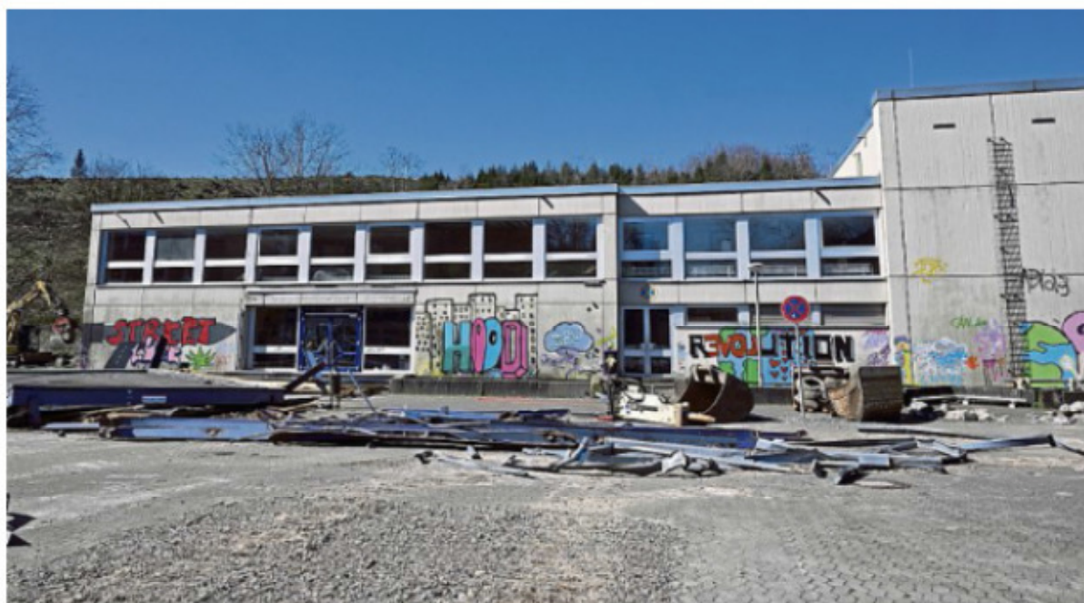
Im April begannen die Bauarbeiten an der Gesamtschule Kürten. Nun wurde bekannt, dass die Heizungsanlage marode ist.
