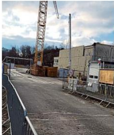
Die Baustelle am Kürtener Schulzentrum. Foto: cbt
