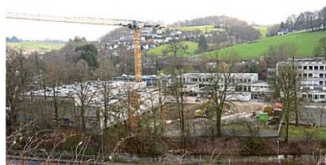
Die Schulsanierung in Kürten soll fortgesetzt werden.
