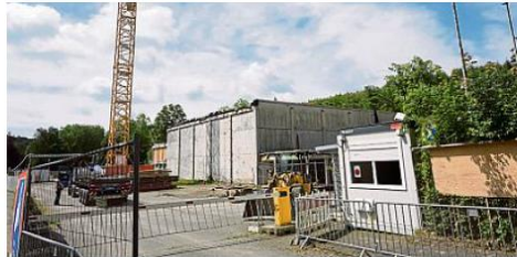
Die Baustelle an der Gesamtschule.
