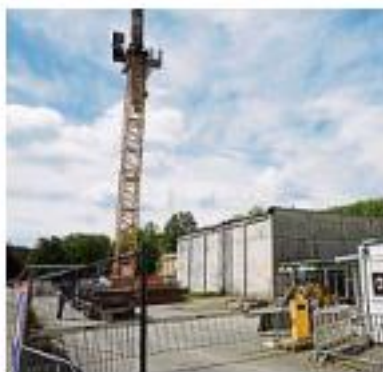
Das Schulzentrum Kürten ist derzeit eine Baustelle. Foto: Arlinghaus
