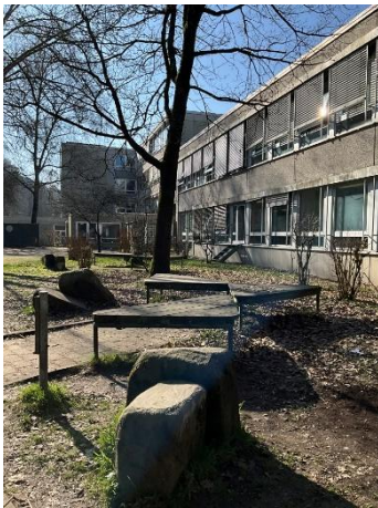
Abbildung 29: Blick von Norden auf Außenbereich und Hinterseite von Geb. N, im Hintergrund Geb. H
