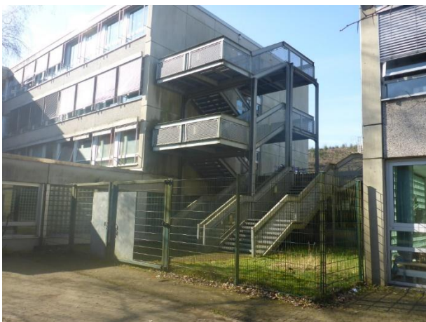
Abbildung 31: Blick von Nord-Ost auf Außenflucht- treppe des Geb. H
