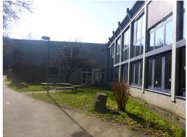
Abbildung 28: Blick von Norden auf Geb. S (rechts) und N (mittig)
