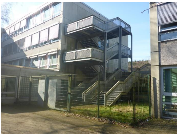
Abbildung 32: Blick von Nord-Ost auf Außenflucht- treppe des Geb. H
