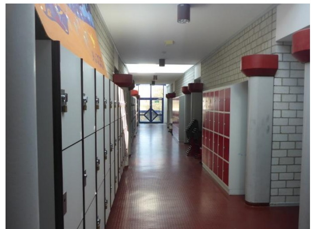
Abbildung 27: Blick auf Flur (1. OG) Geb. S, im Hintergrund Außenfluchttreppe Richtung Norden (Wipperfürther Str.)
