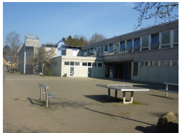
Abbildung 17: Pausenhof mit Blick von Süden auf Geb. N (rechts) und Geb. S (im Hintergrund)
