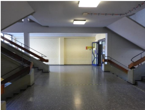
Abbildung 22: Treppenhaus Geb. H+M
