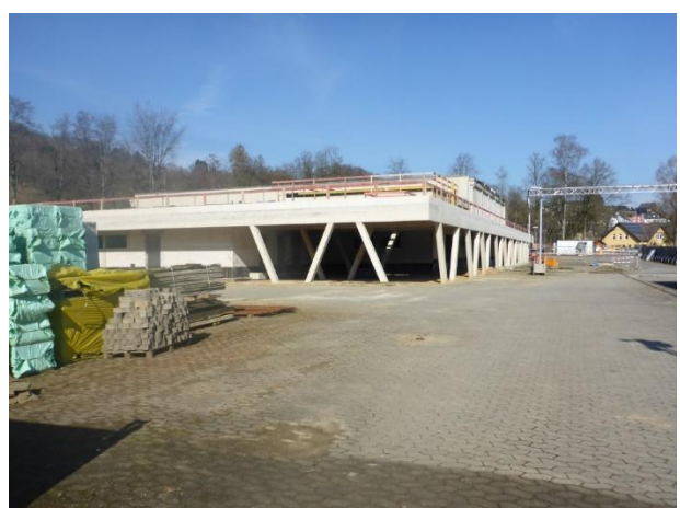
Abbildung 19: Blick von Süden auf MZH (B-Bau)
